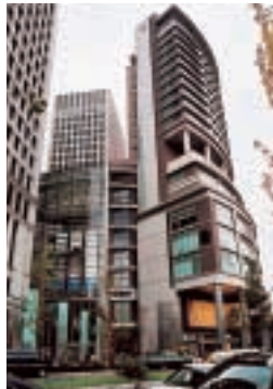
■丸の内本店が入居した「丸の内オアゾ」内の商業・ホテル施設棟外観。
