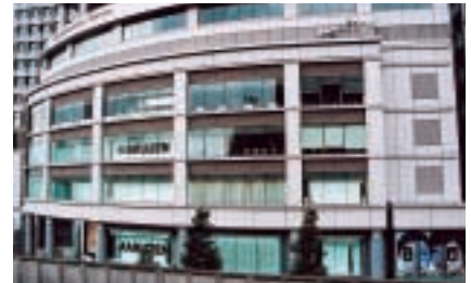
■丸の内本店1階から4階の外観。
