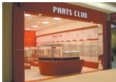
■施工中の「パーツクラブ 水戸イオン店」
